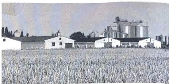
Wer ins sächsisch-anhaltinische Baasdorf kommt, dem leuchten die Silotürme des neuen Wimex-Mischfutterwerkes entgegen.
